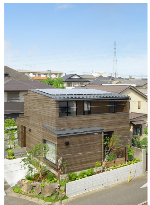
太陽光パネル 4.4kw
