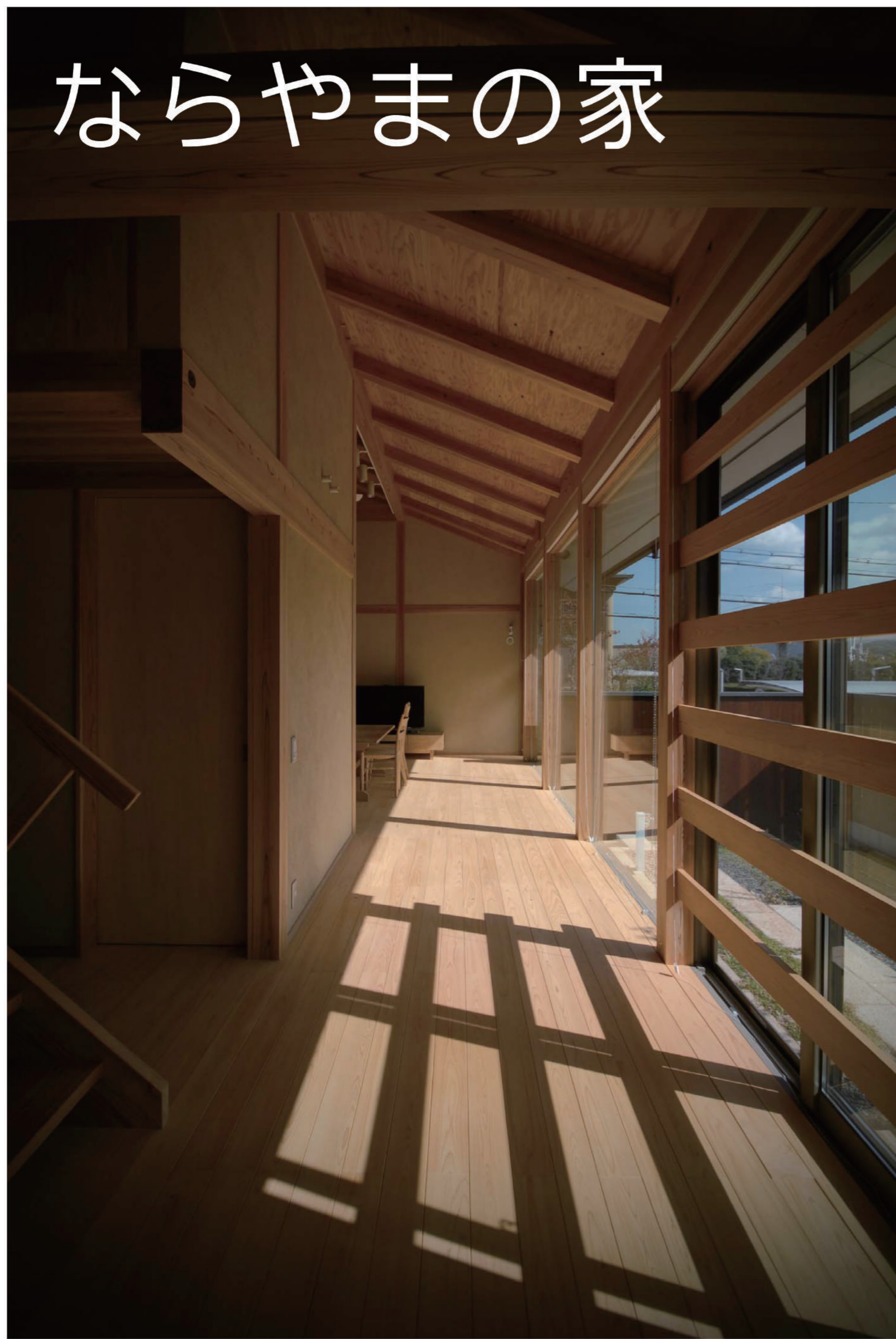
南面障だまりスペース：冬期の日中は日射を取得し、外気温が下がった際、断熱ブラインドで熱損失を防いでいる。
