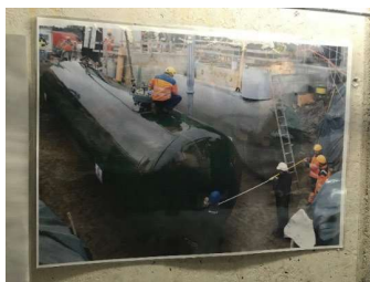
水素貯蔵タンク (建設時)
