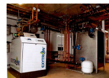
CO2回収装置
