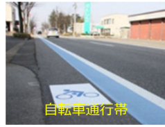
自転車通行帯 自転車が通る場所を青色(青色の矢印)で示しています
