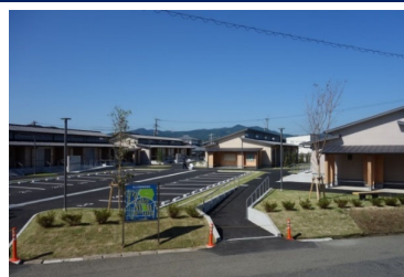
災害公営住宅（東側道路から）
