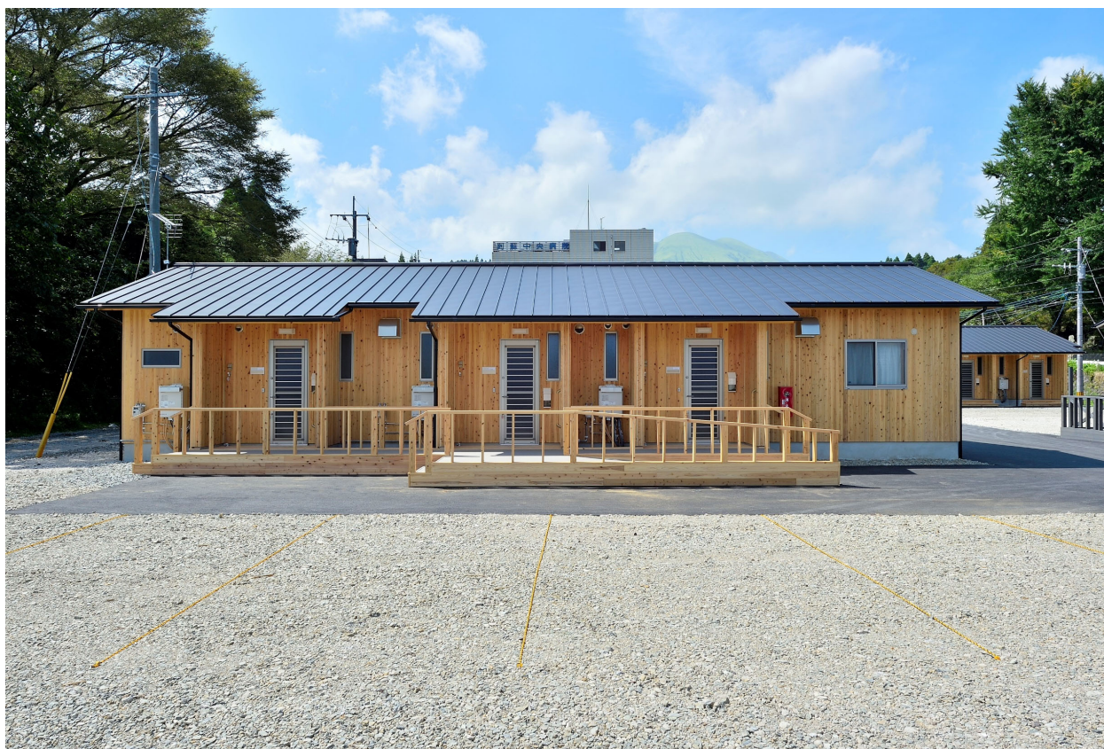
仮設住宅外観（スロープ棟）。
