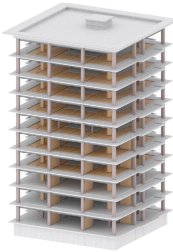
● 建物全体の構成 木造+鉄骨造
