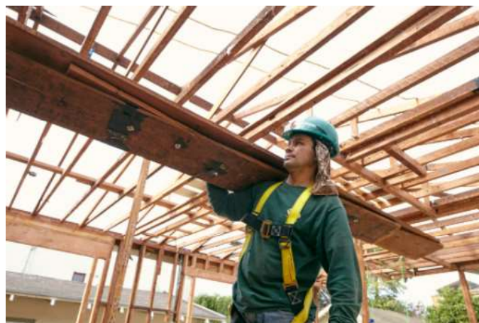
再利用のための手解体
