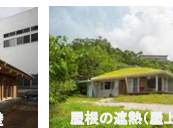
屋根の透熱(屋上緑化)
