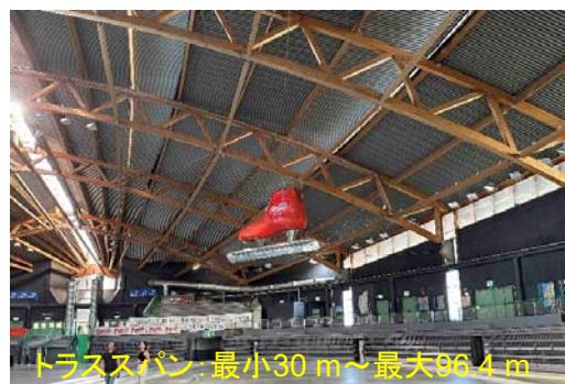
長径260 m、短径96 mの楕円状の平面、最高高さは35 m
