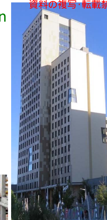
↑現場施工状況 ↓
