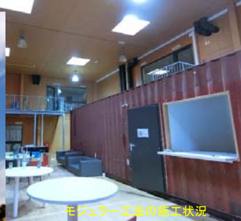
モジュラー工法の施工状況
